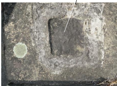
鉄柵支柱の痕跡
