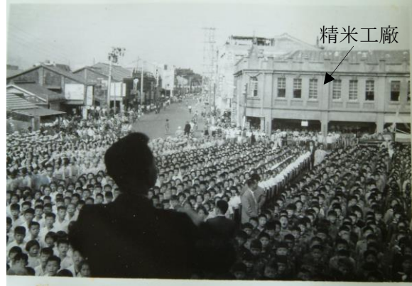
精米工廠 (大甲區公所提供)
